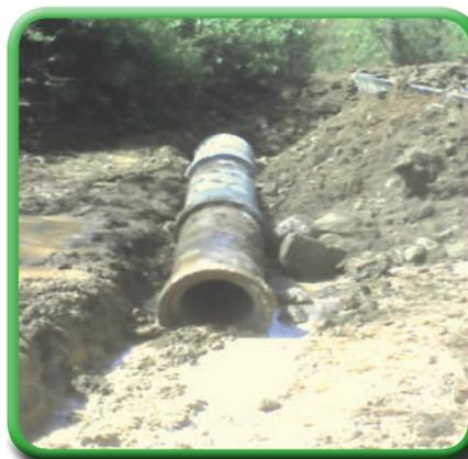
Foto 5. Construcción de alcantarilla usando tubos de concreto de 2 metros de largo.
