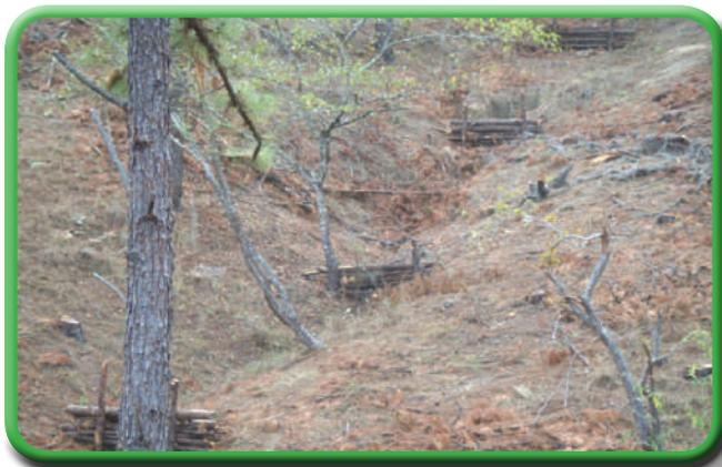
Foto 14. Muros de contención elaborados con residuos del aprovechamiento.
