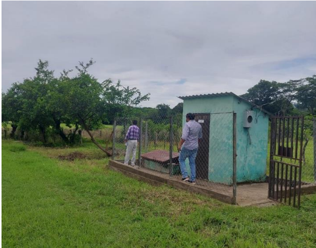
Figura 28. Gira de campo, pozo Altamira
