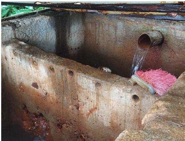
Figura 7. Obra toma del proyecto de agua de la microcuenca San José
