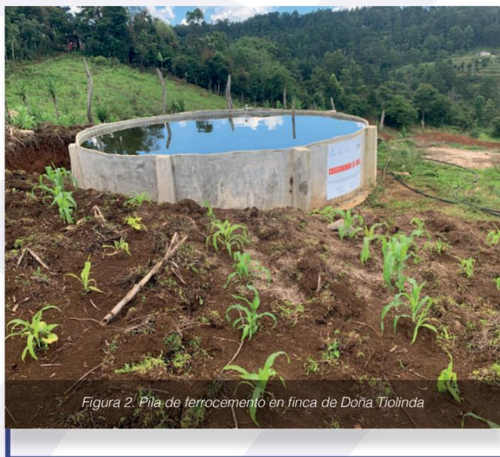
Figura 2. Pila de ferrocemento en finca de Doña Tiolinda
