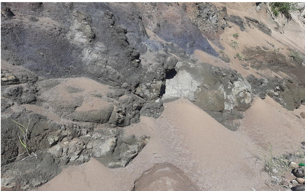
Ilustración 7. Roca en talud de carretera en recorrido biofísico
