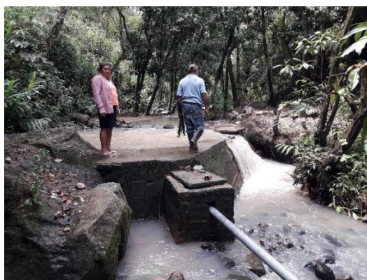
Obra toma, Sistema de Riego Comunidad Las Delicias
