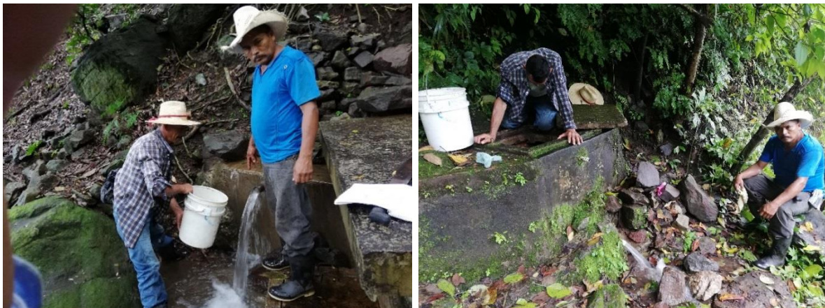
Ilustración 19. Realización de aforos en obras toma de las comunidades de El Ocote y El Picacho en época de invierno
