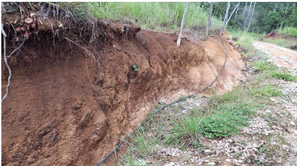
Ilustración 6. Roca en talud de carretera en recorrido biofísico
