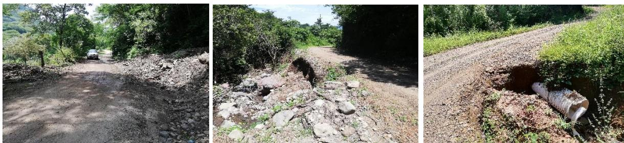
*Ilustración 17. Daños provocados por las lluvias en las vías de acceso de la microcuenca*
