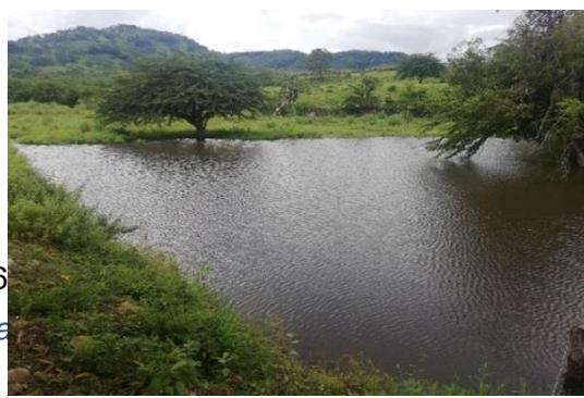
capacidad de almacenamiento de 200 m<sup>3</sup> de agua cada una. La infraestructura se construyó en sitios de la microcuenca con potencial escurrimiento de agua hace la obra, sin embargo, por mala calidad del revestimiento utilizado las cosechadoras de agua no cumplen con la función deseada.
